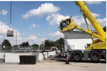
Einbringung der Belüfterplatten mit einem Autokran
