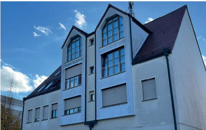
**STARKER SANIERUNGSBEDARF, NÄGEL DER WDVS DÄMMUNG SIND AN FASSADE SICHTBAR, MEMMINGER STR.**
