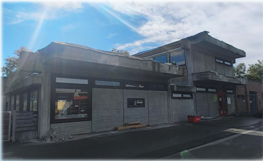
Abbruch der Fassadenteile
