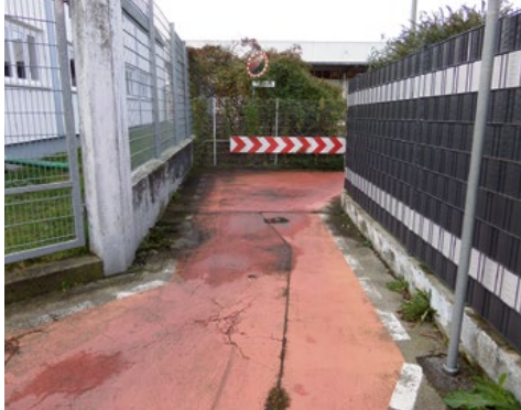
Ansicht von der Weidachgasse
