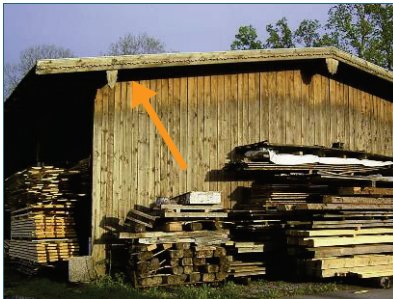
Abb. 1: Quartier von Rauhauffledermäusen im nur zwei Zentimeter breiten Spalt zwischen Windbrett und Balken.
