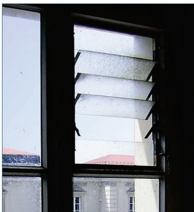
Abb. 17: Ein taubensicherer Zugang für Fledermäuse zum Dachboden des Schlosses Herrenchiemsee.
