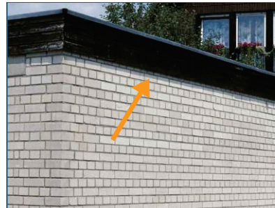
Abb. 2: Wochenstubenquartier von Zwergfledermäusen unter einer Garagenverkleidung.
